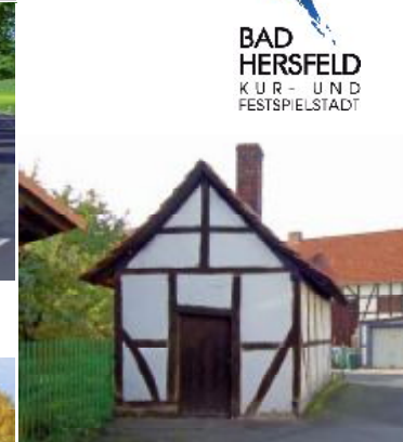
8 Sanierung des historischen Backhauses zur Verbesserung der Nutzungsmöglichkeiten
